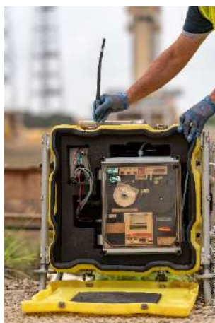
Figure 5 : SPM en cours de mise en place
