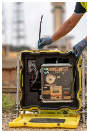
Figure 5 : SPM en cours de mise en place
