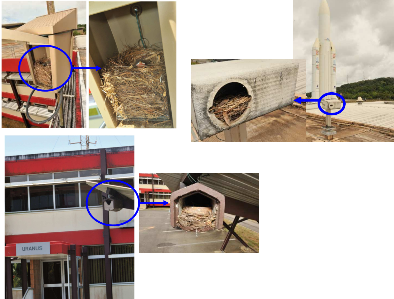
Figure 3 : Nichoirs sur le Centre Technique (CT).
