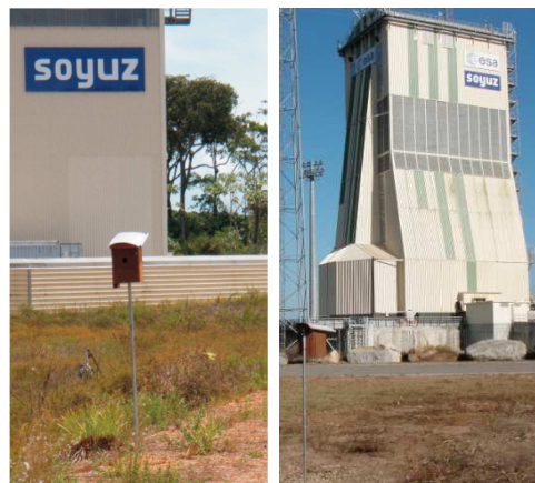
Figure 2 : Installation de nichoirs sur Soyouz.
